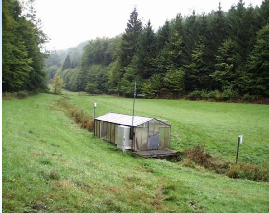
Emergenzhaus mit Messstation
