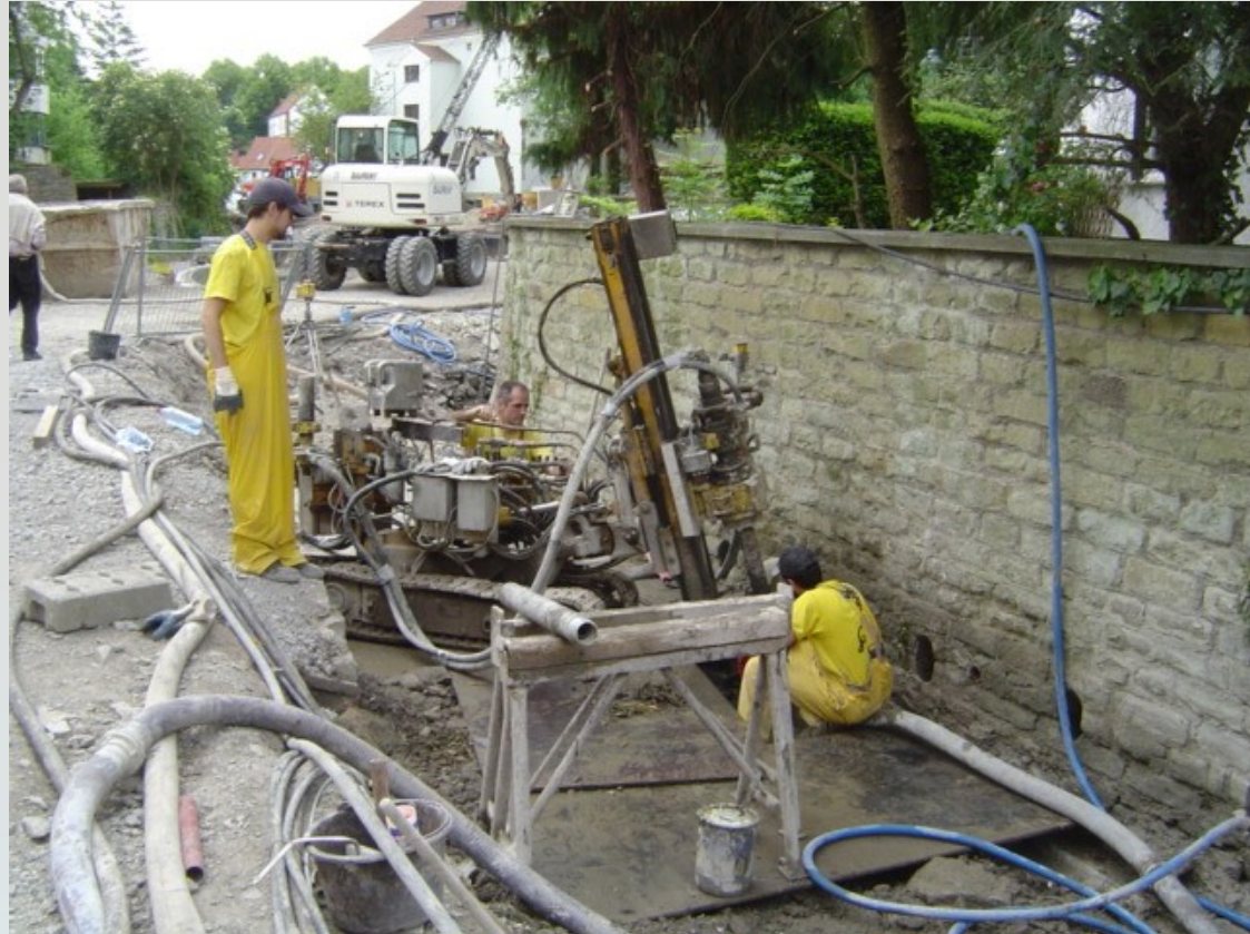
HDI-Verfahren Sicherung alter Grünsandstein-Mauern
